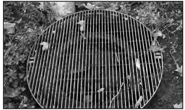
Photo #5--Silo transformer.
